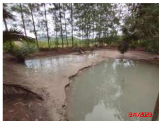
รูปที่ 14 ปอดักตะกอนของโครงการ
